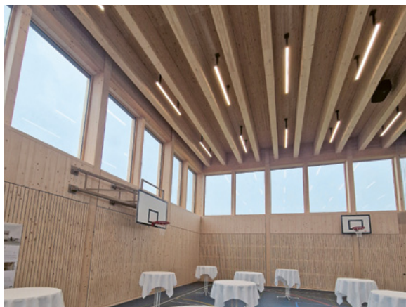
565 m 3 Holz aus dem Staatswald wurden in den neuen Sporthallen des Bildungszentrums für Technik (BZT) in Frauenfeld verbaut.
